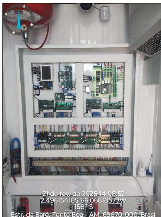
e) Figura 05 – Manutenção no painel de automação;
