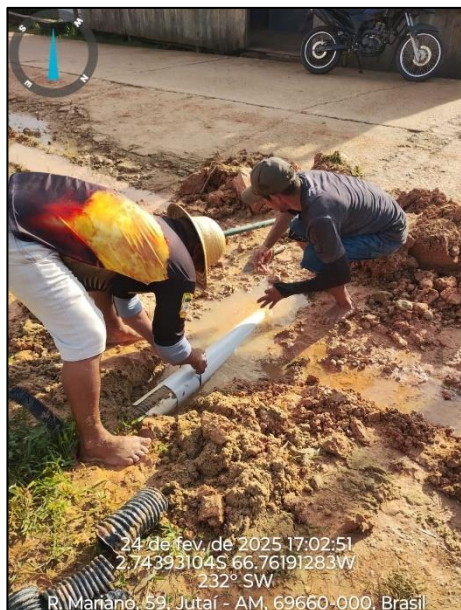
b) Figura 02 – Manutenção no cano flex da fibra óptica;
