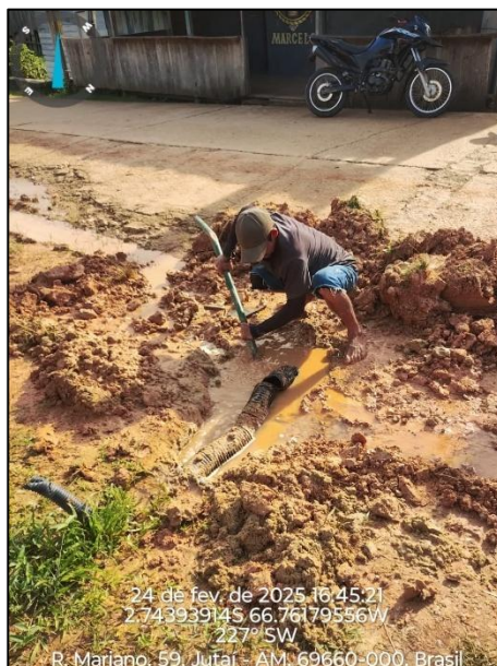
b) Figura 02 – Manutenção no cano flex da fibra óptica;
