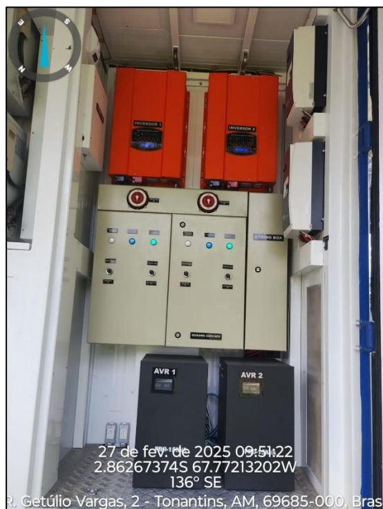
g) Figura 07 – Manutenção na área de energia.
