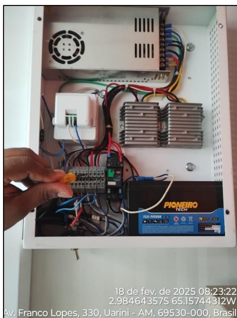
f) Figura 06 – Manutenção da fonte.
