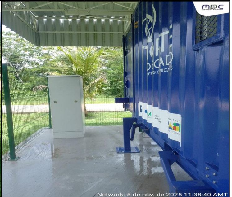
Lateral direita após o processo de limpeza.
