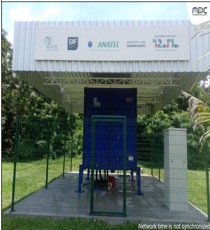
Estrutura geral após o processo de limpeza.
