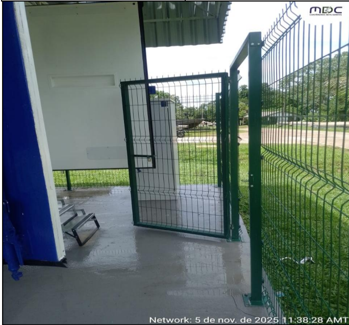
Portas frontais após o processo de limpeza.
