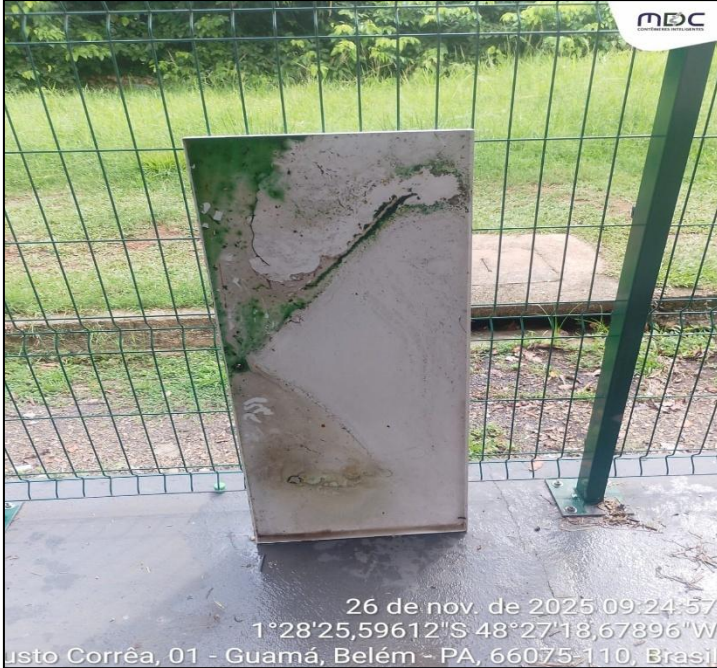
Bandejas apresentando elevado nível de sujeira antes da execução do processo de limpeza.
