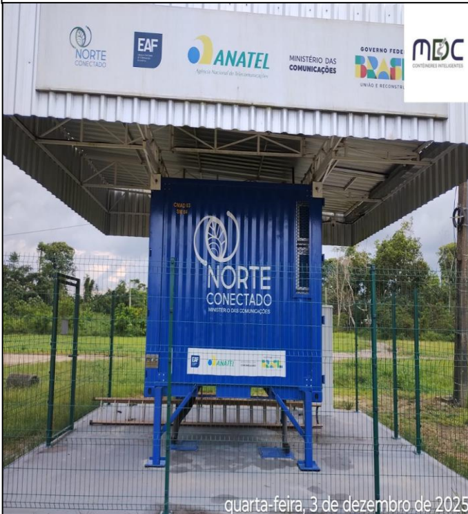
Estrutura geral após o processo de limpeza.
