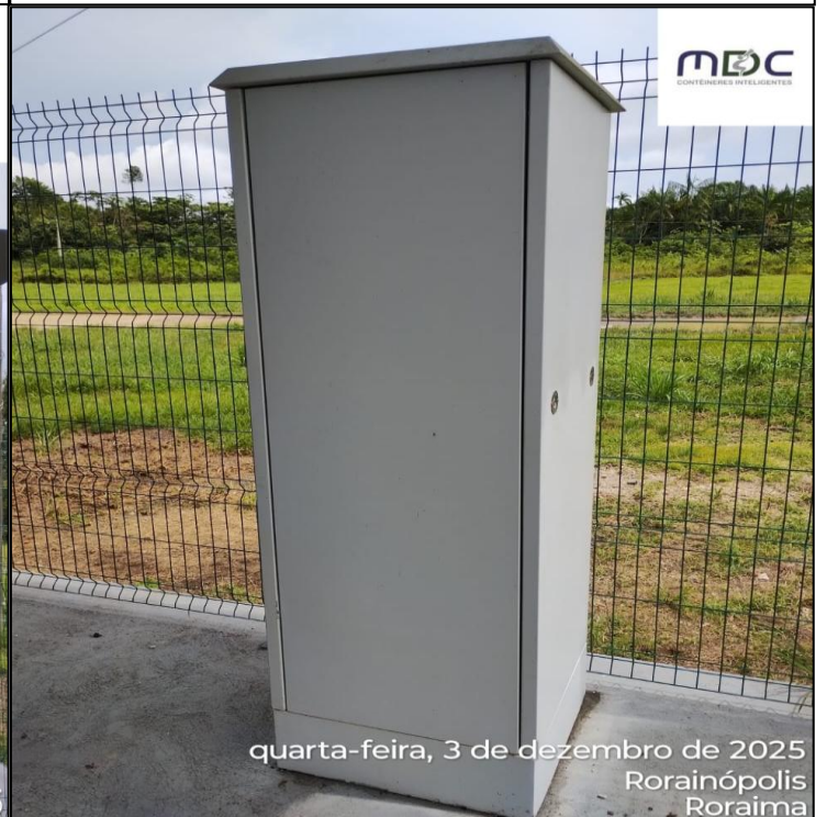
Gabinete após o processo de limpeza.
